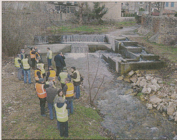
OUVRAGE. Techniciens du SIGAL, élus, représentants d'associations... se sont retrouvés au pied de la passe à bassins.
